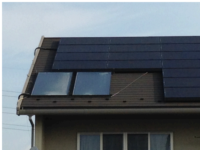
わが家の太陽光発電（左手前の2枚は太陽熱集熱パネル）
